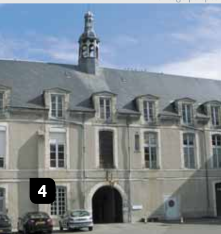
The Vendôme hospital (Frankrig) montage på spær
